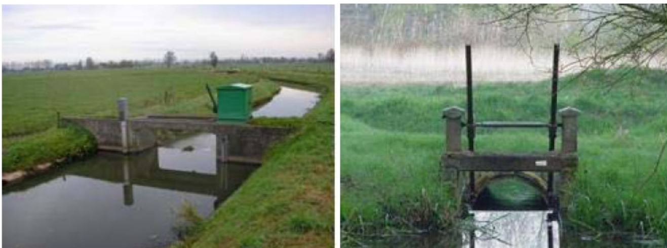
Εικόνα 11: Μικρός υδατοφράχτης (αριστερά) και υπερεκχειλιστής (δεξιά) 11
